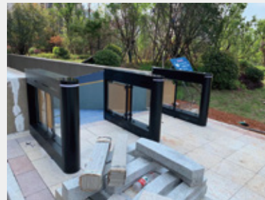
湖南某小区地下车库步行入口
