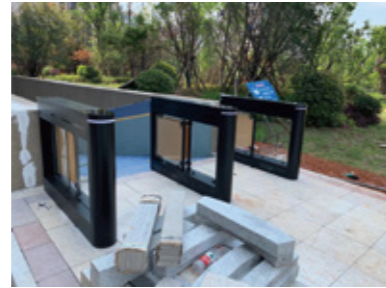
湖南某小区地下车库步行入口
