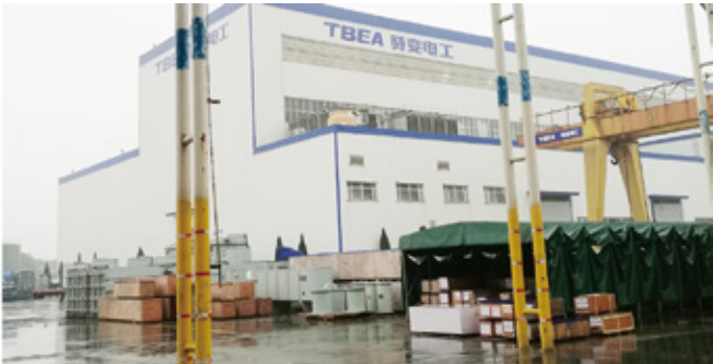
特变电工变压器厂仓库管理
